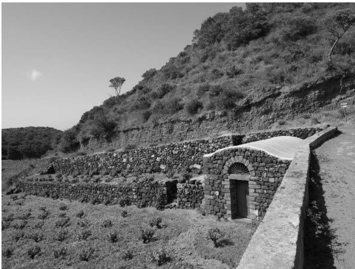
Pantelleria non ha acqua dolce, quindi i residenti hanno costruito muri terrazzati di roccia lavica porosa, come questi sul lato sud dell'isola, che bloccano il vento e irrigano frutta e verdura con la rugiada.
