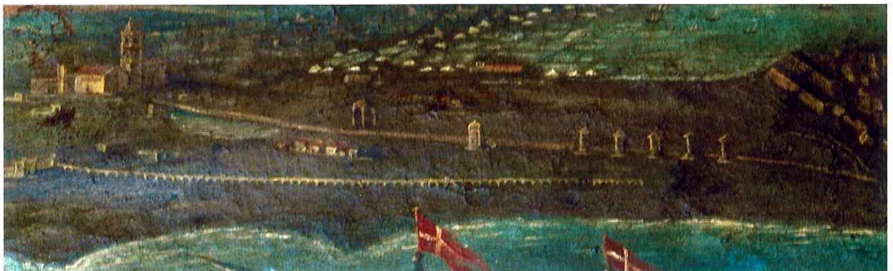
idem, particolare con veduta della strada per il Santuario
