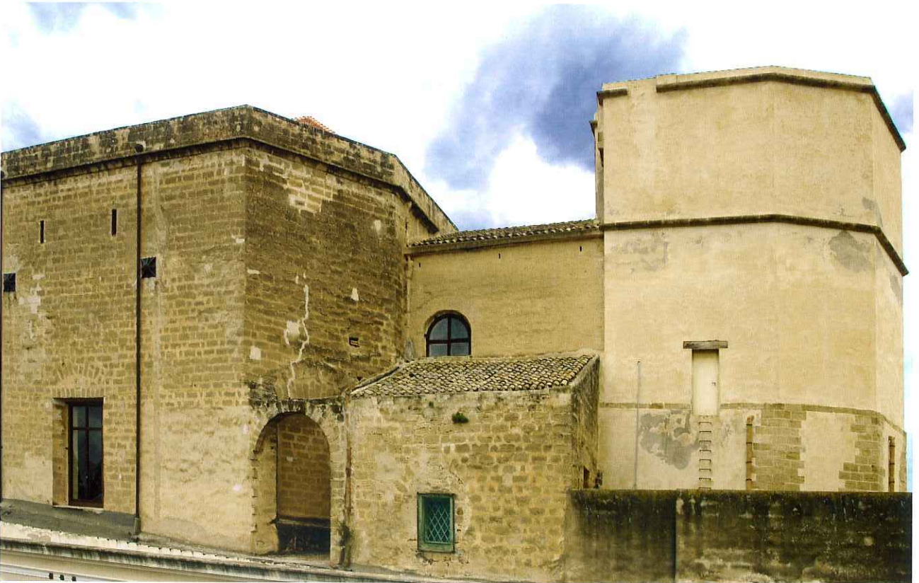
Una fotografia del secolo scorso, della copertura e del tiburio-torre della chiesa gotica, rialzati nel Settecento, e della Cappella della Madonna, addossata all'abside nel primo Cinquecento. Archivio V. Scuderi. La configurazione settecentesca dello spazio già di copertura del transetto della chiesa gotica. Fotografia G. Scuderi.
