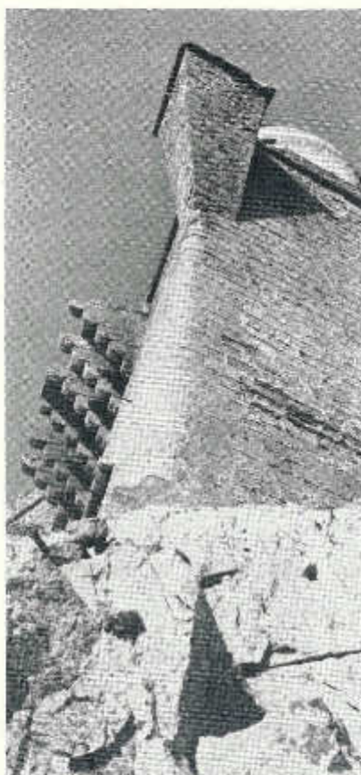
I sei mensoloni che sporgono dall'area meridionale servirono forse a sostenere una veranda panoramica della quale non esiste più traccia. Ma hanno ugualmente una loro suggestione
