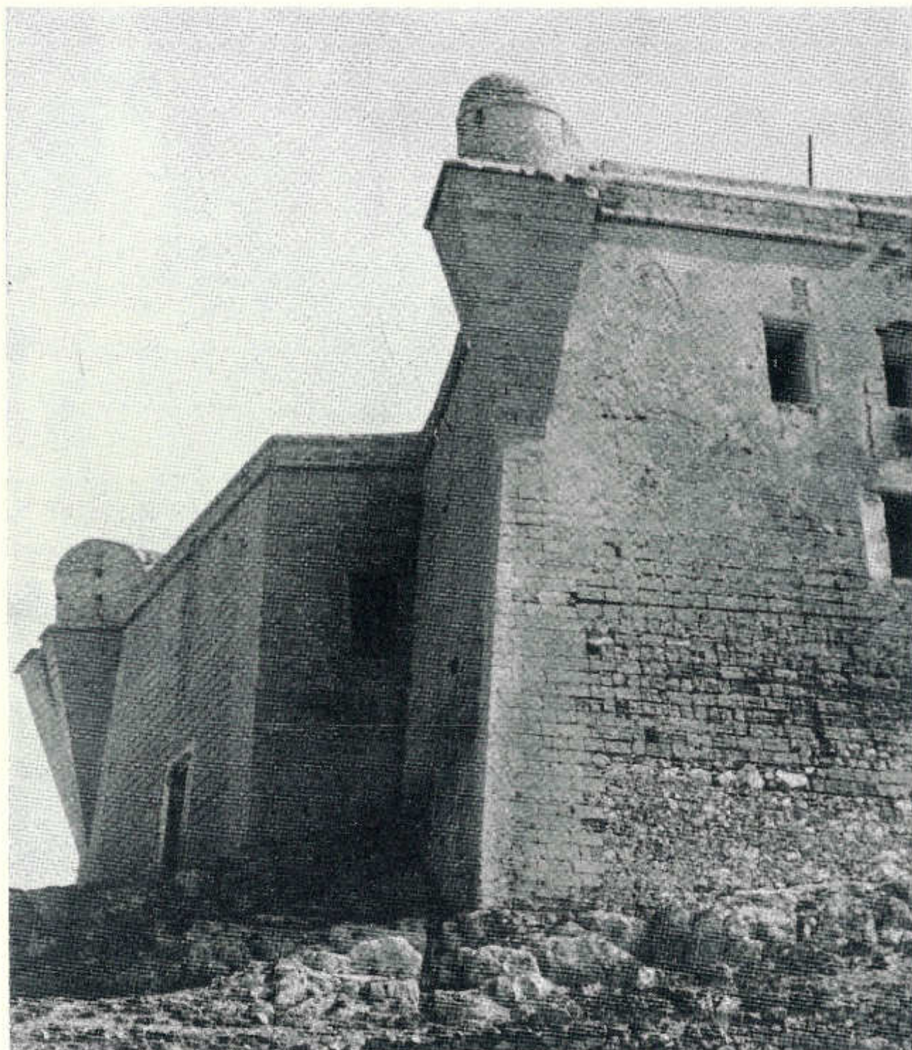
La fortezza, specialmente nei corpi aggettanti difesi da torrette poggianti su barbacani, è costruita con grossi conci di tufo color giallo-ocra, spesso corrosi dalla salsedine. Qua vediamo uno scorcio dell'ala che mostra, per la mancanza di infissi, i segni dell'inizio di un processo di fatiscenza
