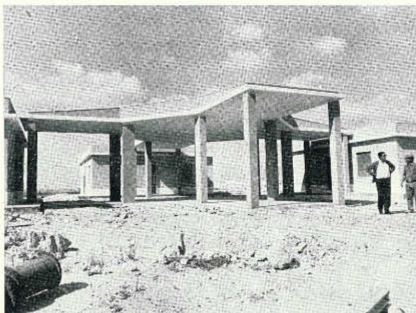
Casa di guardia del serbatoio di carico di Campobello di Mazara per lo acquedotto Bresciana di Trapani
