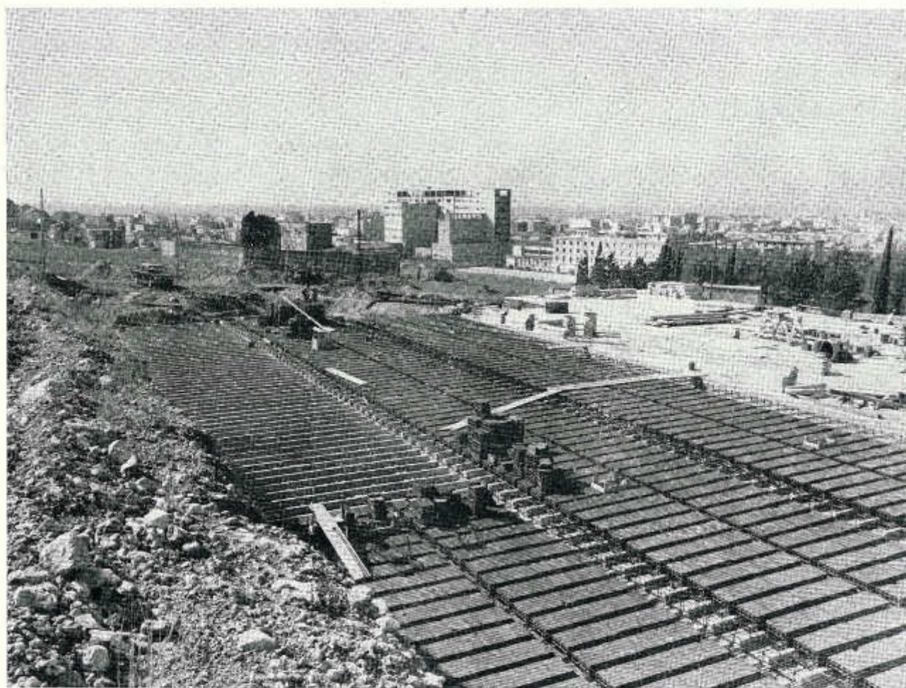
Soletta di copertura del serbatoio Martogna, per l'alimentazione ad anello dell'abitato di Trapani
