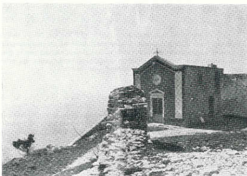
Un lato delle mura del lato inclinato S-SE con la chiesa della Madonna dell'Alto nella più recente edizione del sec. XX. Si scorge la parte terminale della rampa di accesso che si snoda sotto il tratto di mura che qui si vedono in primo piano
