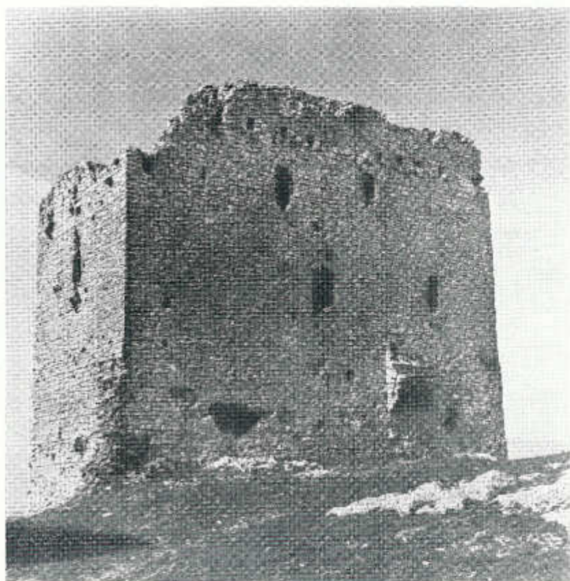
La grande torre di NO veduta da SE; con i resti delle strutture di impianto, rilevabili in planimetria, è l'elemento meglio valutabile di tutto il castello di Bonifato. Si notano i resti delle mura di cinta allo attacco con i fianchi della torre; l'accesso avveniva attraverso il varco più grande del primo piano (nella fotografia quasi al centro del fianco più grande)
