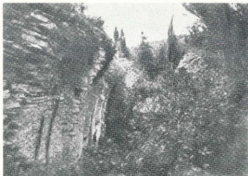
L'interno della « fontanazza » con i resti degli arconi; vi si scorgono i fori trasversali che servirono a sostenere l'armatura per la costruzione della volta
