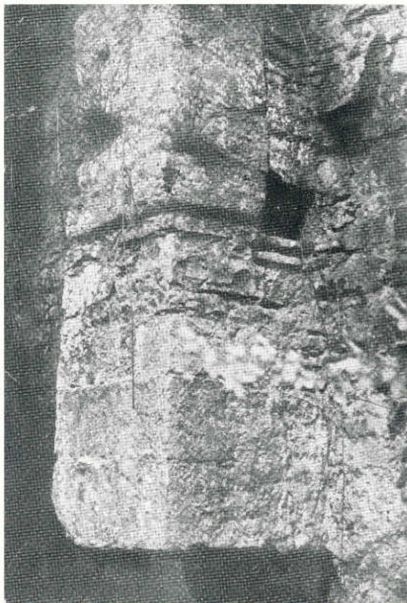
L'unico peduccio rimasto degli arconi della « fontanazza »; le pietre squadrate continuano nell'intradosso, mentre il resto dell'arco si lega con le strutture murarie. Si scorge la cornice leggermente sagomata ed uno dei fori per la costruzione della volta
