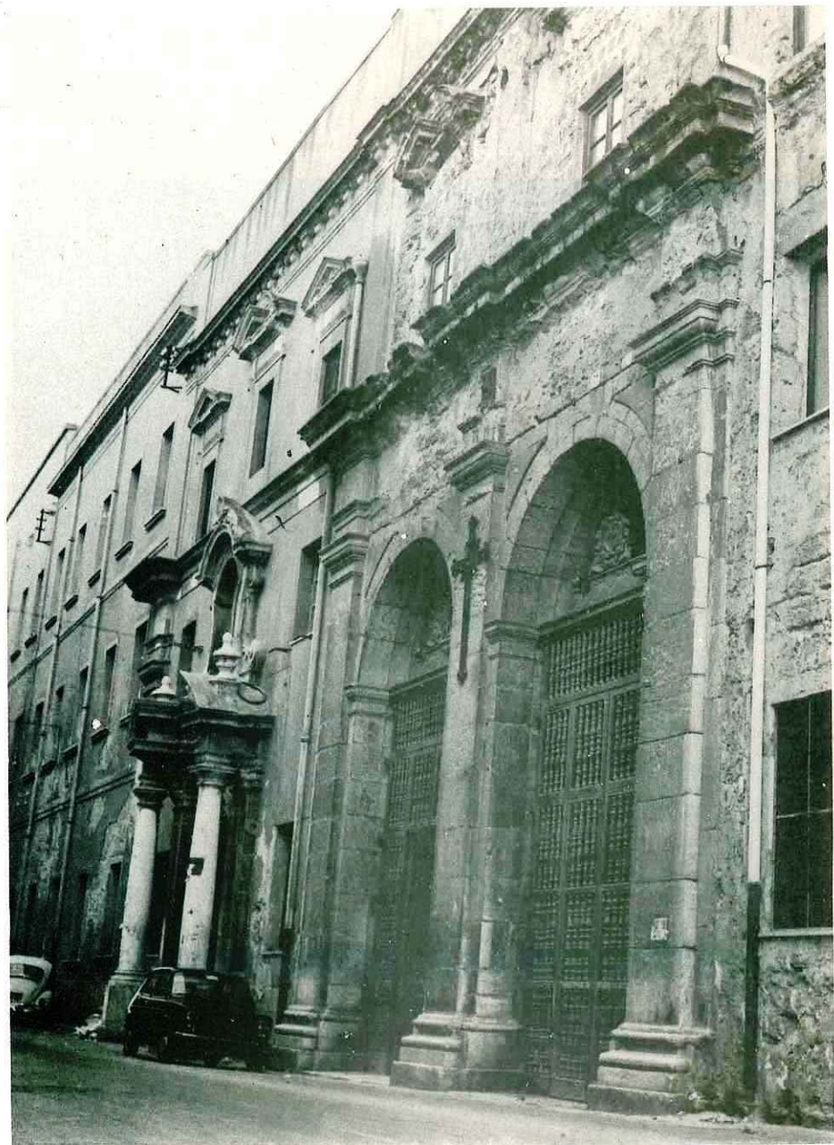
Fig. 2 - La facciata della chiesa allo stato attuale.
