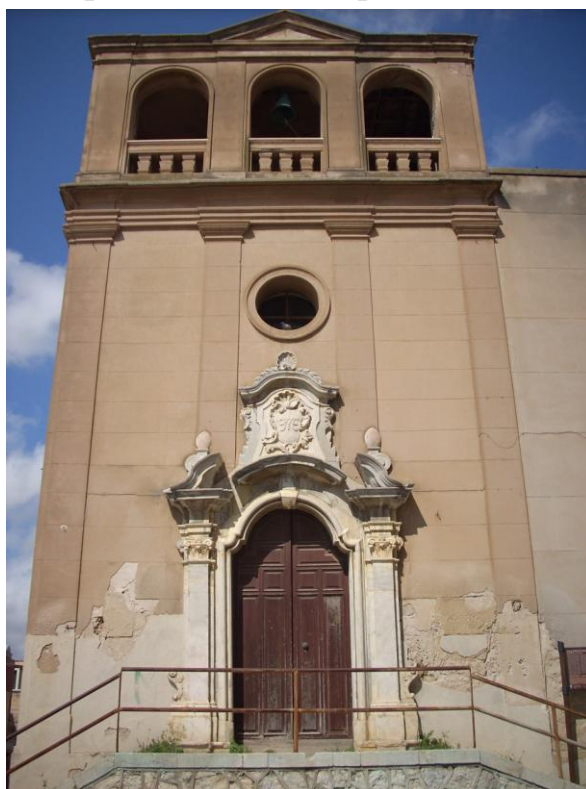
Facciata della Chiesa prima del restauro del 2022
