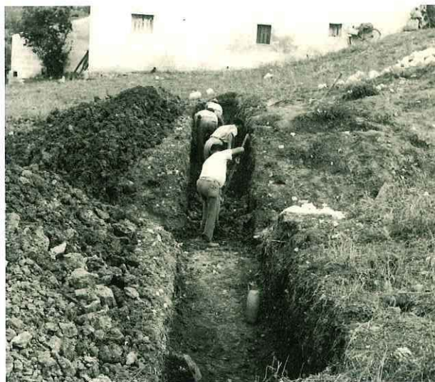
N° 197. Lavori di urbanizzazione a Crocevie anno 1954 - 1955
