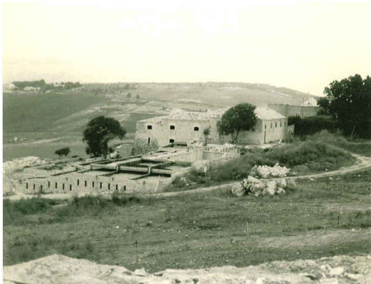
N° 25. Anno 1985. Il Baglio Santacroce in avanzata fase di ristrutturazione.
