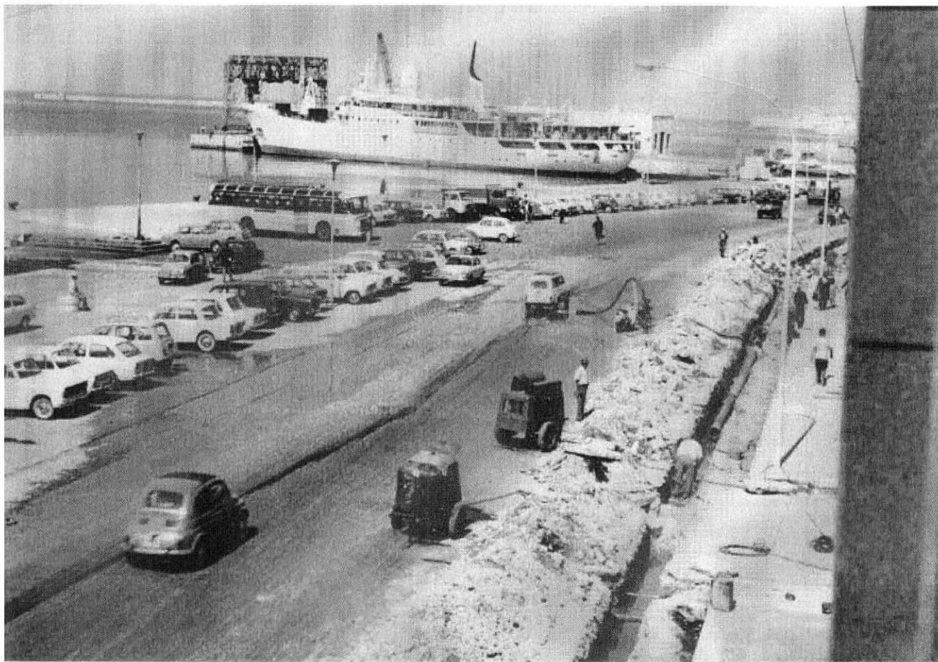
Lavori nella città vecchia, via Ammiraglio Staiti.
