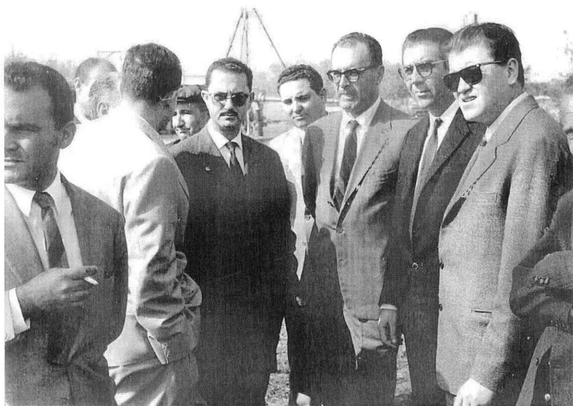
Amministratori, Consiglieri Comunali e Tecnici in visita ai pozzi in fase di trivellazione
