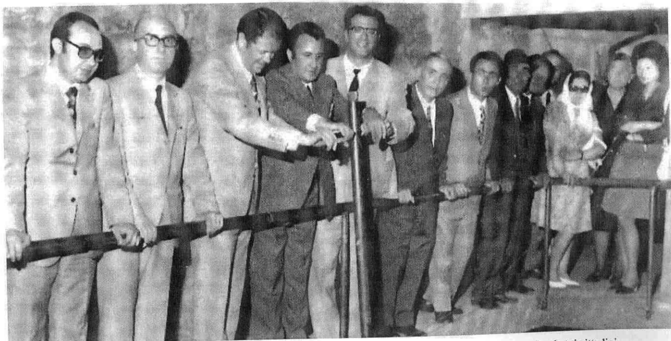
Il Sindaco Catania aiuta l'Ing. Lombardo a chiudere la saracinesca di scarico ed immettono l'acqua nei serbatoi cittadini.
