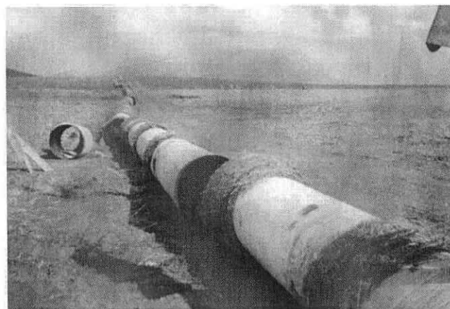
Tubi d'acciaio depositati lungo il tracciato dell'acquedotto; sullo sfondo si intravede Erice
