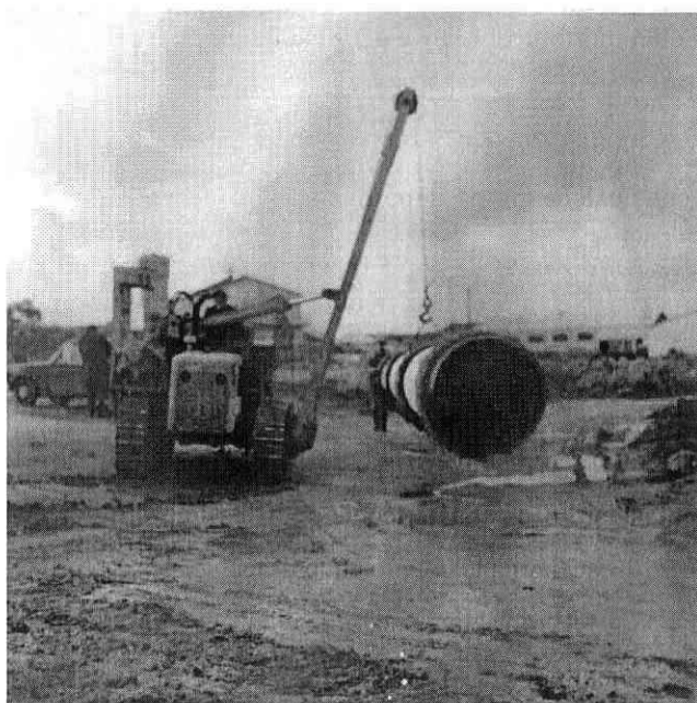
Tubi in corso di collocazione.
