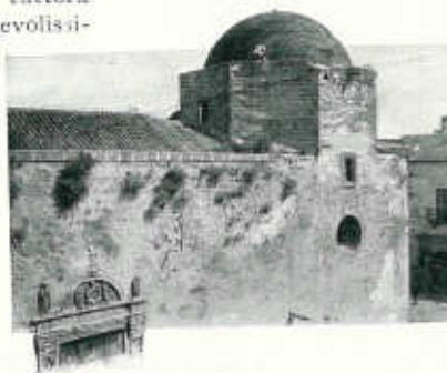
MAZZARA - CHIESA DI S. EGIDIO.
