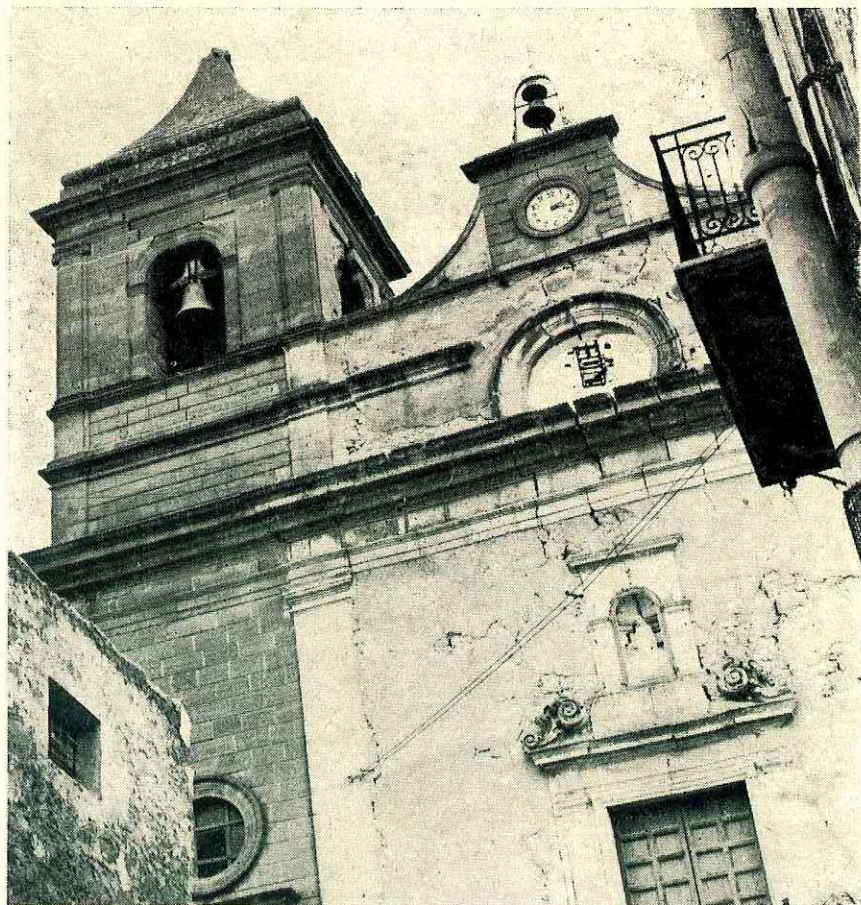
L'orologio sulla Madrice di Poggioreale, il cui interno è crollato, si è fermato alle ore 3,10 del 15 gennaio 1968 nel momento stesso cioè in cui una tremenda scossa di terremoto ha distrutto il paese
