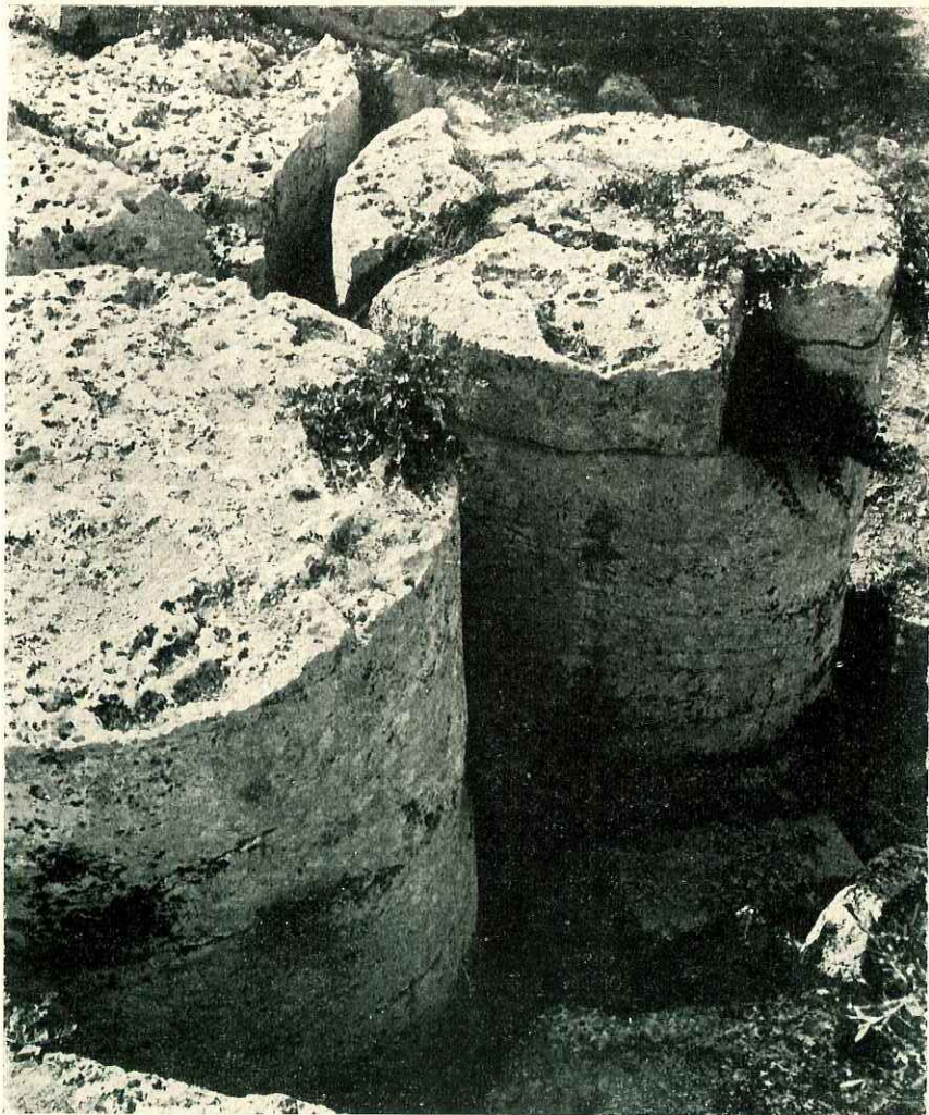
Particolare delle «Cave di Cusa» da dove i Selinuntini traevano il materiale per la costruzione dei loro templi
