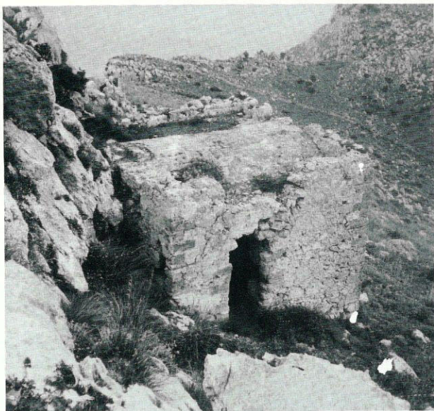
Fig. 8 - Dammuso di Gallo: le precarie condizioni della torre posta a ridosso della cortina di rocce e dello strapiombo del Malopasso.
