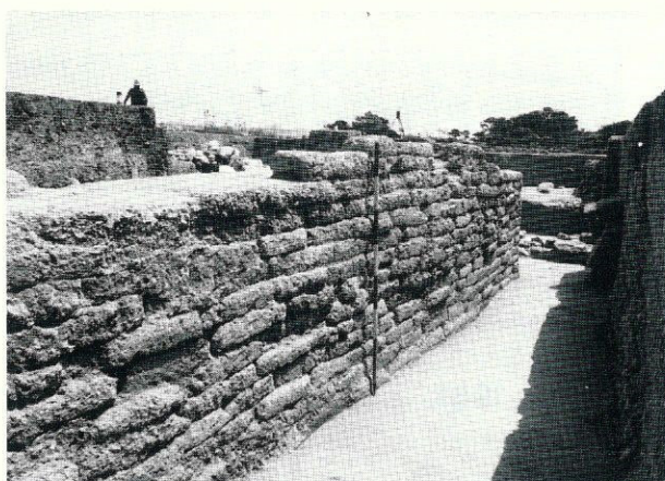
Fig. 9 - Area 53. Il paramento esterno del muro in mattoni crudi. (da N.N.W.)
