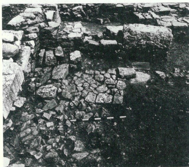
Fig. 15 - Agorà, particolare dello scavo sul lato est dell'edificio di IV secolo. Da ovest. Al centro affiora, integrato nel lastricato del cortile, un muro dell'edificio di V secolo.
