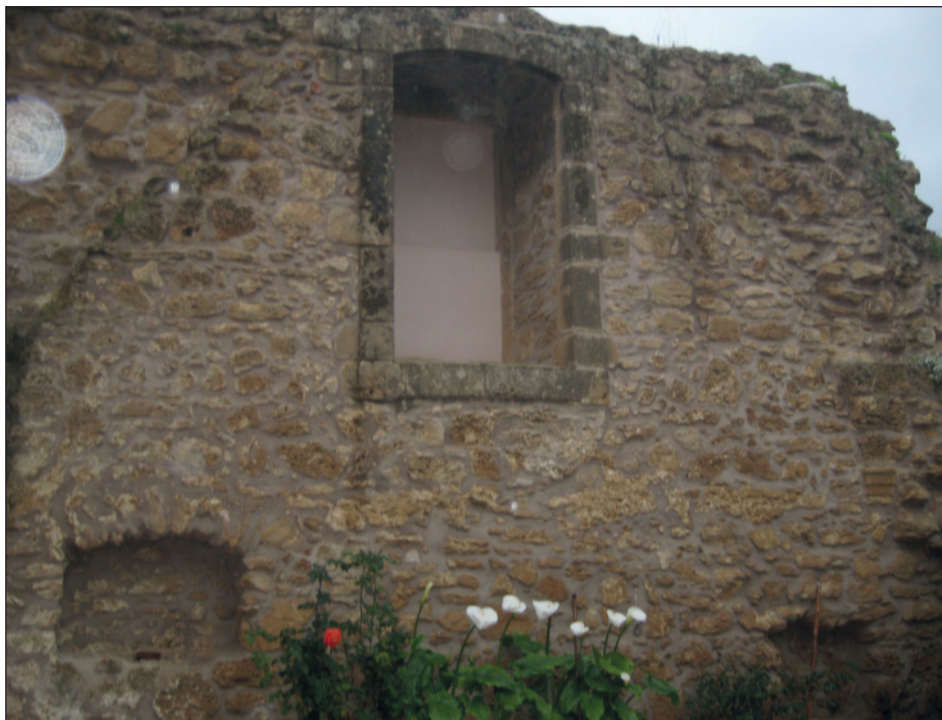
Muro perimetrale con resti della prima chiesa poi abbattuta (foto A. Barbata)
