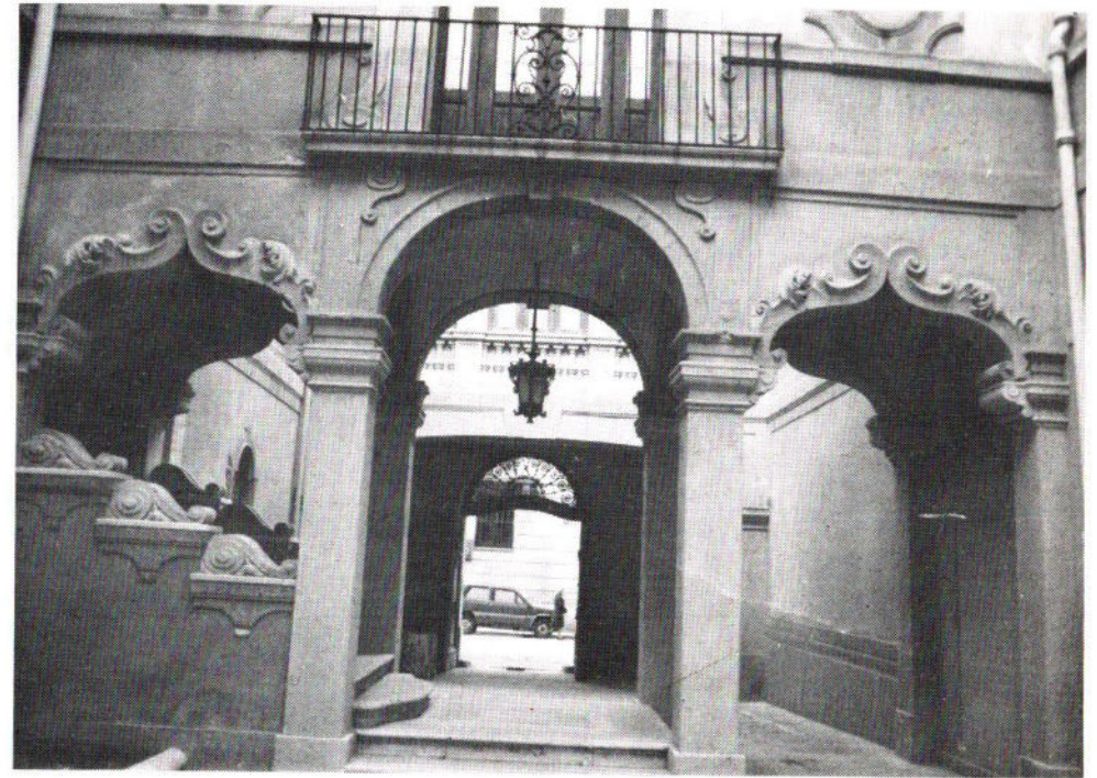
Palazzo di don Giovanni Ferro. Particolare del cortile
