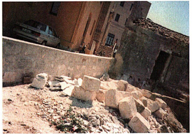
Discarica di "sfabbricidi" presso la chiesa secentesca di Misericordia (arch. fotograf. di G. Ettari).
