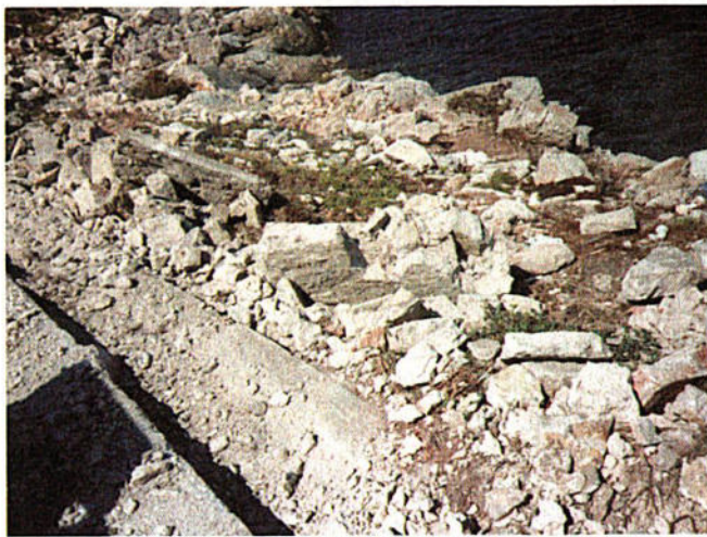
"Sfabbricidi" abbandonati lungo la S.P. Trapani-Bonagia-San Vito Lo Capo, 9° km, in seguito a demolizione di muretto contenitore e sua sostituzione con guard-rail (arch. fotograf. di G. Ettari).
