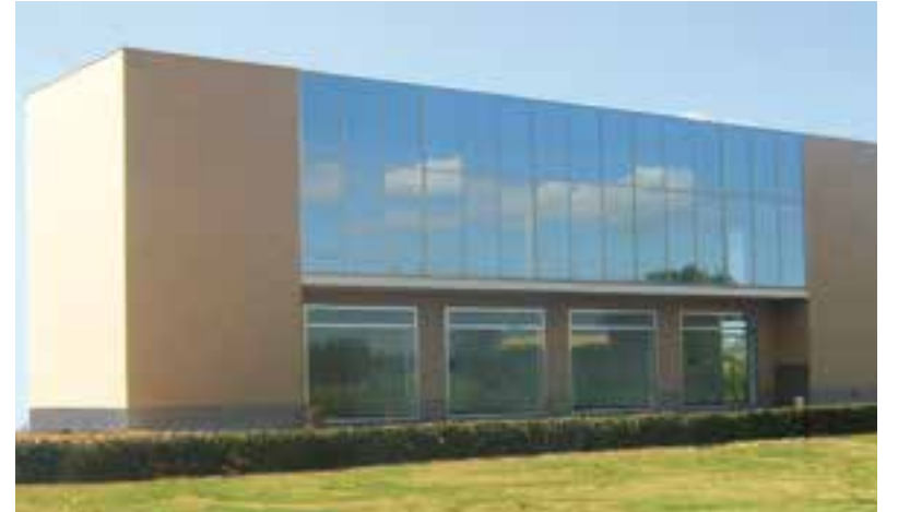
La sede della Medica.it a Marsala in C.da Terrenove
