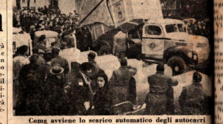
Come avviene lo scarico automatico degli autocarri
