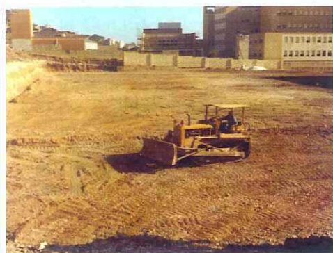
1968: Iniziano i lavori del campo «Ricceri»
