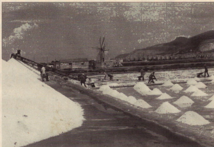
Mulino in contrada Maria Stella lungo la strada provinciale Trapani-Marsala operai impegnati nella raccolta del sale
