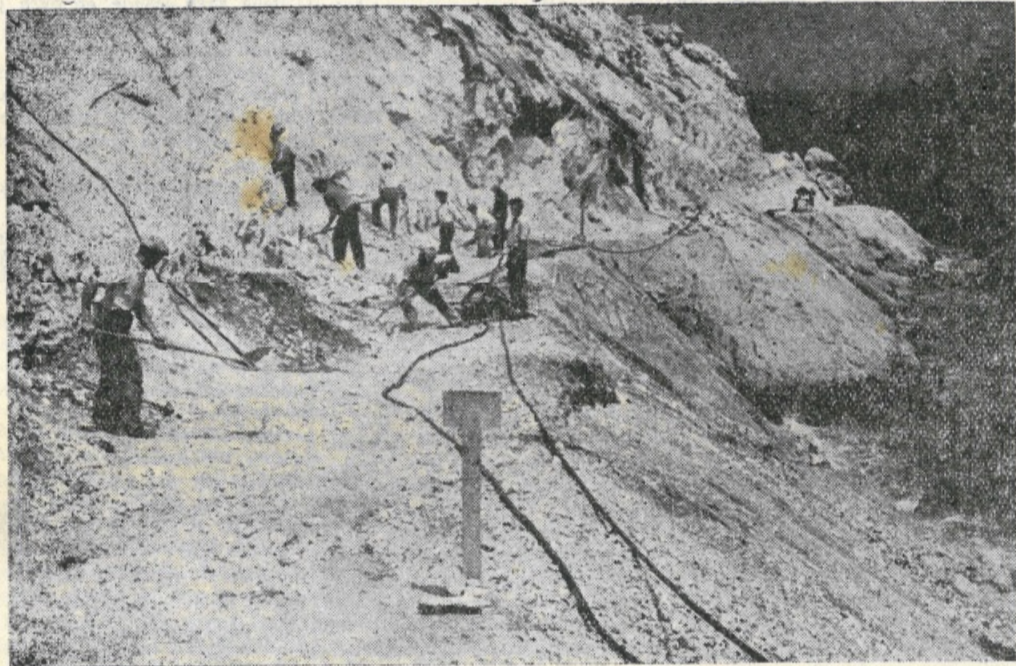
Si costruisce la strada di accesso al porto (Fotografie Bonventre)
