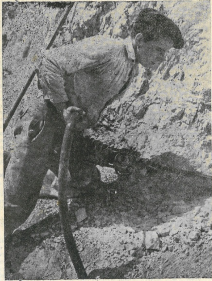
Martello perforatore in funzione
