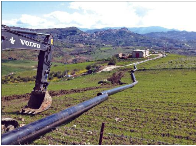
Lavori alle condutture idriche; a destra l'assemblea idrica
